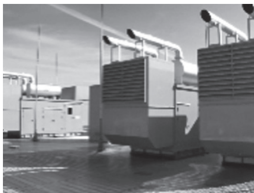
免震屋上への非常用発電機設置
